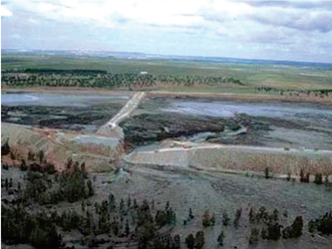
Figura 8 - Ruptura da barragem “Los Frailes” (Davies et al. 2002, apud Freire Neto, 2009).
